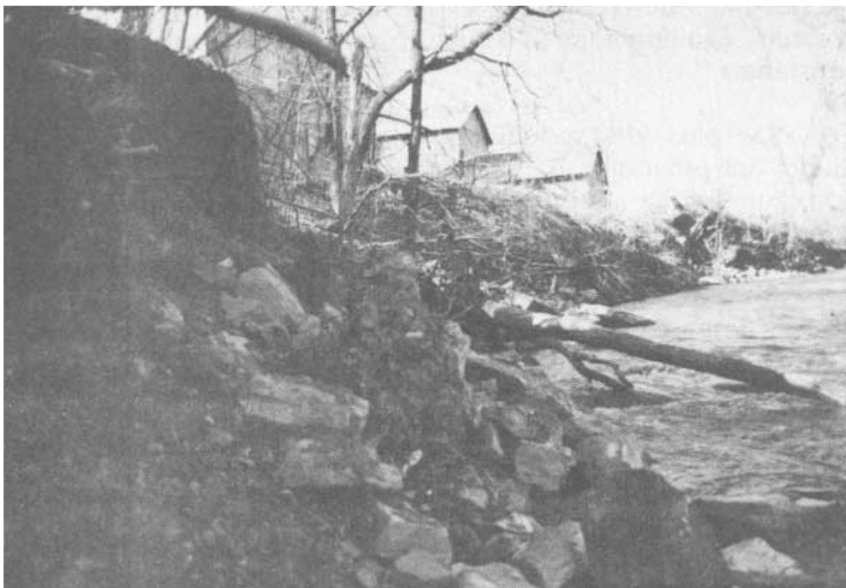
L'érosion des berges, à l'arrière du moulin de la Dalle.
